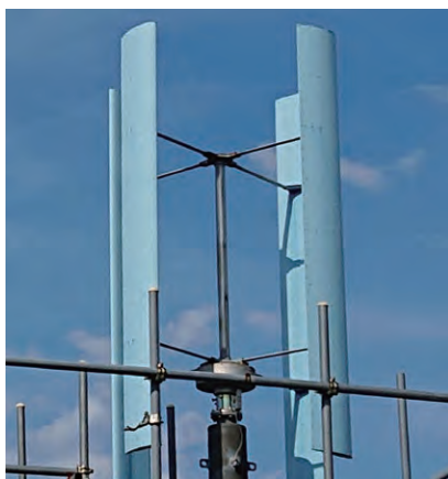
太陽光発電と併用した小型風力発電機 Small-scale wind power generator used in conjunction with solar power generation
